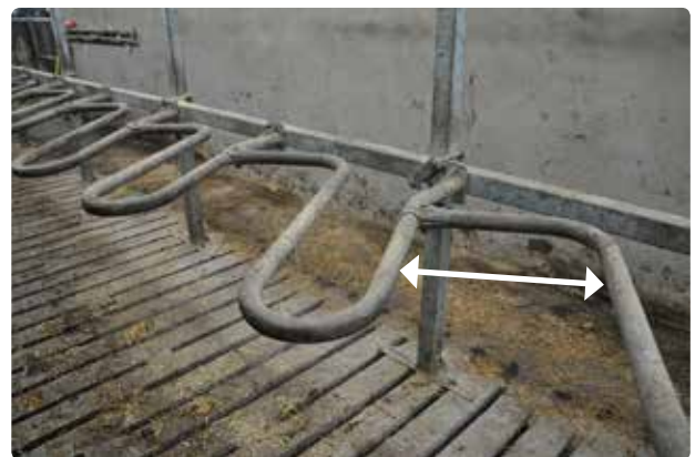
Figur 2.37. Kopladsens indvendig mål er 0,44 meter.
