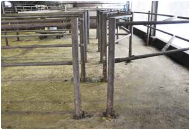
Figur 2.69. Mandehuller på tværs af drivgangene giver let passage rundt i behandlingsafsnittet for personalet. Se også skitsen.
