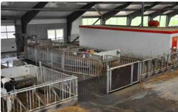
Figur 2.16. Klovbeskæringsboks og tilhørende drivgang ved siden af separationsafsnit.
