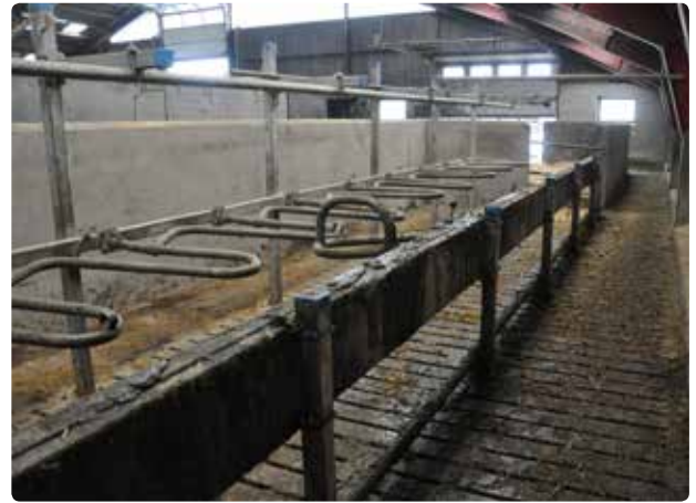
Figur 2.43. En 1,1 meter bred arbejdsgang bag ved køerne. Kvægbrugeren vurderede, at bagbommen sidder i en passende højde (overkant sidder 0,94 meter over ståsted).
