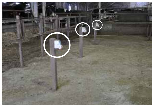
Figur 2.68. Forenden af hver drivgang er der et 400 volt el-udtag til brug ved klovbeskæring.
