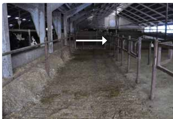
Figur 2.62. Opsamlingsareal med spaltegulv hvorfra køerne drives ind i behandlingsgangen. Pilen viser indgangen til behandlingsgangen.
