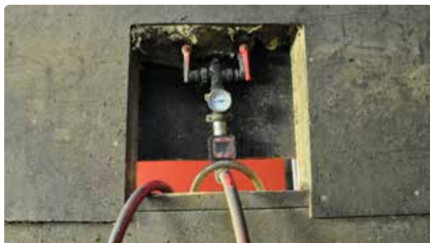
Figur 2.78. Vandmængde og vandtemperatur kan let bestemmes i det aggepumpe-lignende pumpesystem.
