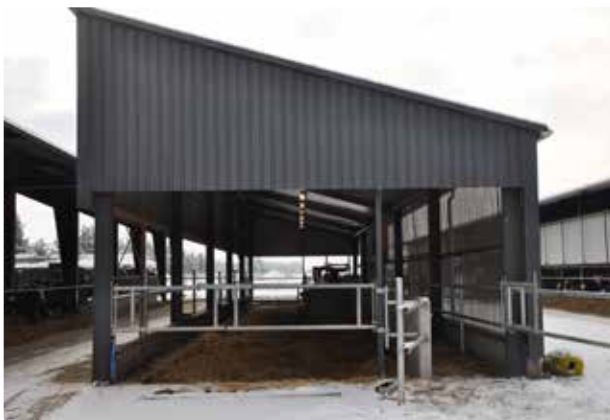
Figur 2.27. Selvtændig bygning med klovbeskæringsboks, interne udleveringsfaciliteter, boks til dyr i behandling og drivgange.
