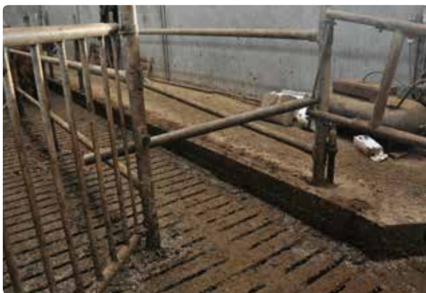
Figur 2.59. Lågen er ikke placeret tilstrækkeligt på skrå, til at køerne placerer sig den rette vej med hovedet væk fra spalterne i behandlingsgangen.
