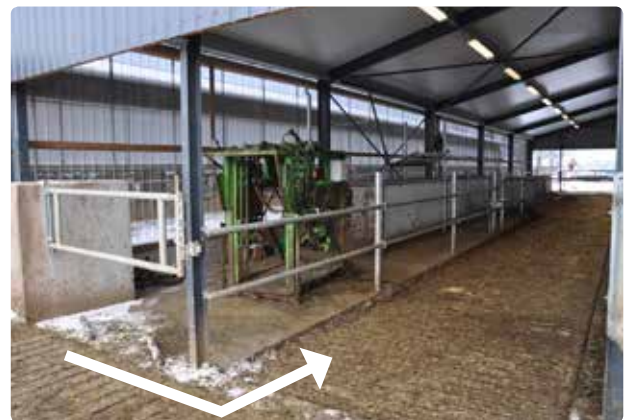
Figur 2.28. Et kig ind i bygningens anden ende, med spalter på ædepladsen. Pilen viser dyrenes vej ind i bygningen fra den udvendige drivgang.
