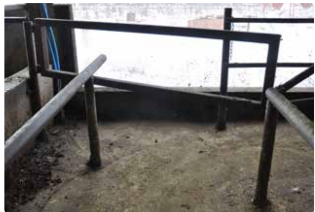
Figur 2.72. Lågen for enden af behandlingsgangen sidder i en vinkel på ~ 65°. Da dyrene står i en vinkel på 45-50°, anbefales det også at placere lågen i en vinkel på 45-50°.
