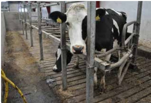
Figur 2.44. En 1,1 meter bred arbejdsgang foran køerne og fri adgang til køernes hoved giver gode behandlingsmuligheder og fx mulighed for påsætning af halsrem. Frontbommens overkant sidder 0,87 meter over spaltegulvet.
